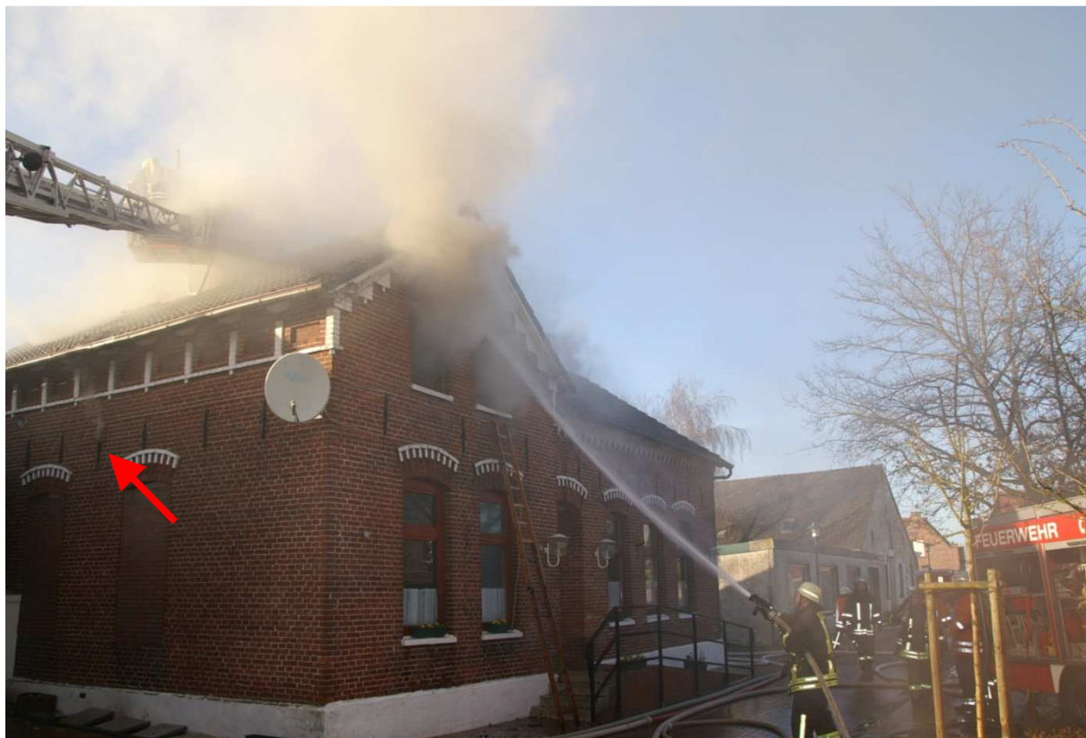
Bild 11: 17:28 Uhr – Die Dachhaut wird über die Drehleiter geöffnet. Nachdem kurzzeitig der Außenangriff unterbrochen wurde, nimmt die Rauchentwicklung wieder zu. Sogar aus einem Maueranker in der Außenwand dringt Rauch. Das Feuer hatte sich in die Hohlschichten der Wände und Decken gefressen und konnte anfangs dort nicht abgelöscht werden. Hier lag wohl der Grund für eine Durchzündung in einem so späten Einsatzstadium.
